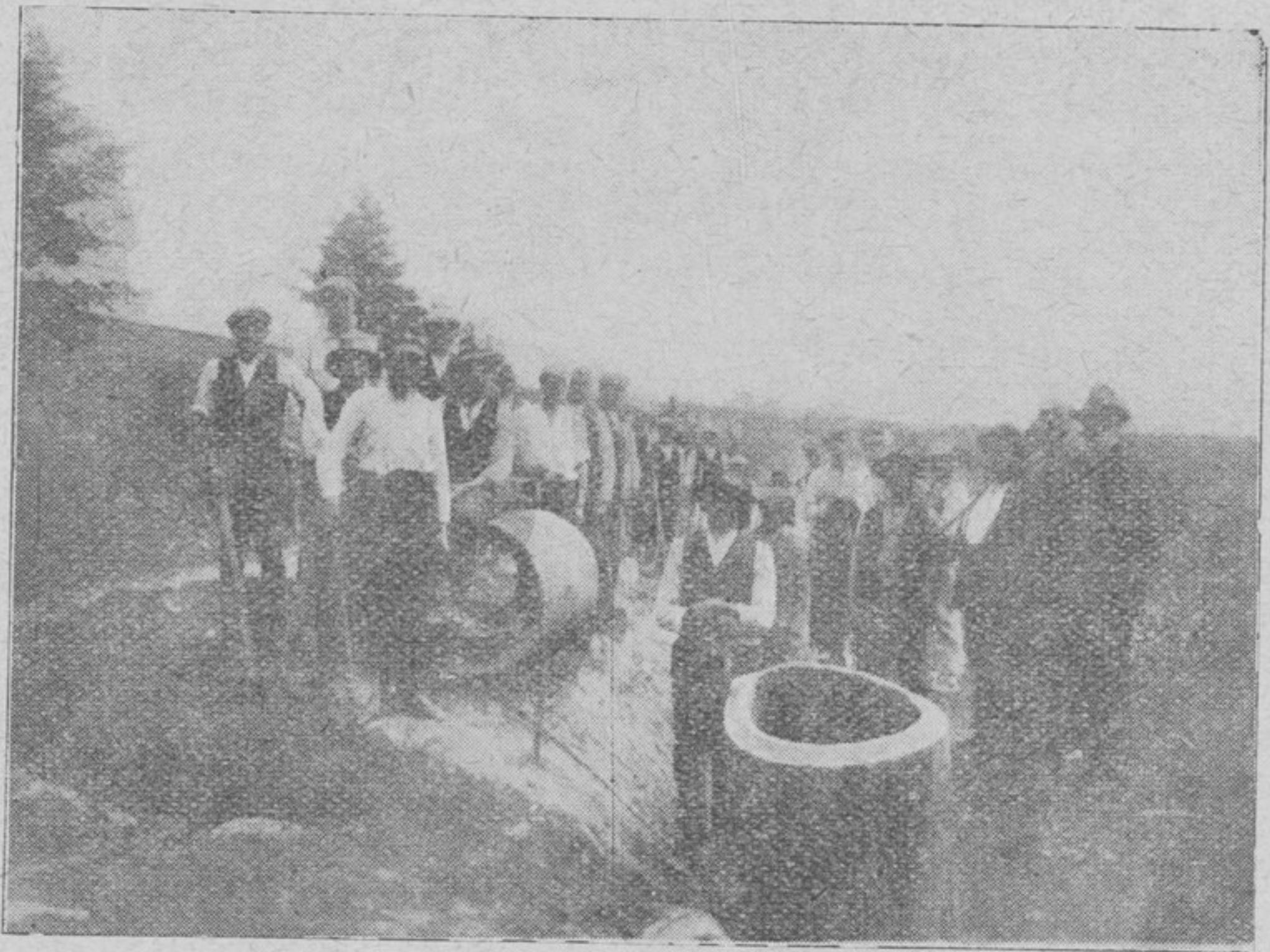
При будові дороги в повіті сяноцком.
